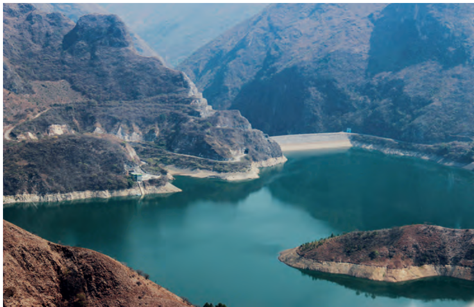
Foto 3. El embalse de la hidroeléctrica Chixoy (Guatemala).
