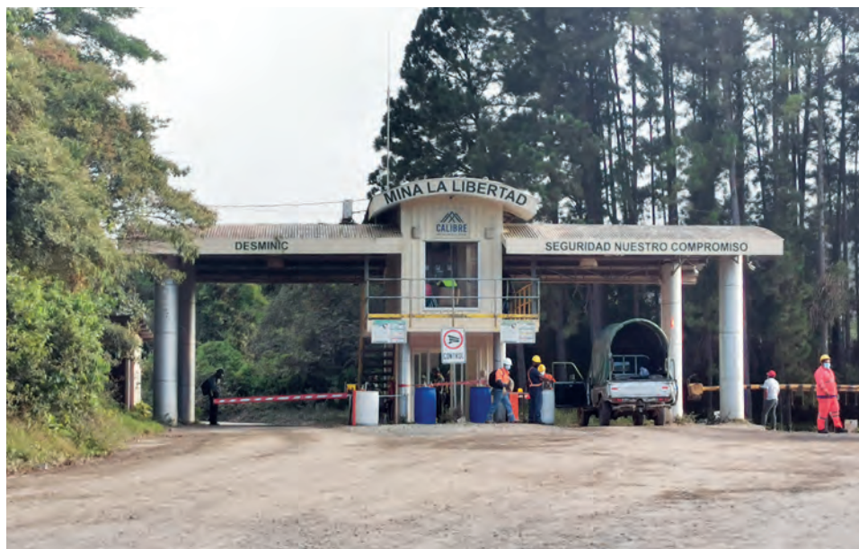
Foto 8. Entrada a la Mina La Libertad (Calibre Mining Corp.).
