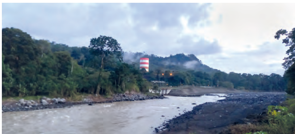
Foto 2. El río Reventazón (Costa Rica) y las estructuras de la hidroeléctrica: el tanque de oscilación (rojo y blanco), el edificio de la casa de máquinas, donde están las turbinas de generación, el área de retorno del agua al cauce.
