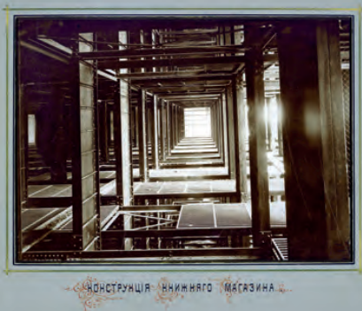
Konstrukcja magazynu książek w gmachu Biblioteki Cesarskiego Uniwersytetu Warszawskiego, fotografia nieznanego autora, 1897, BUW
