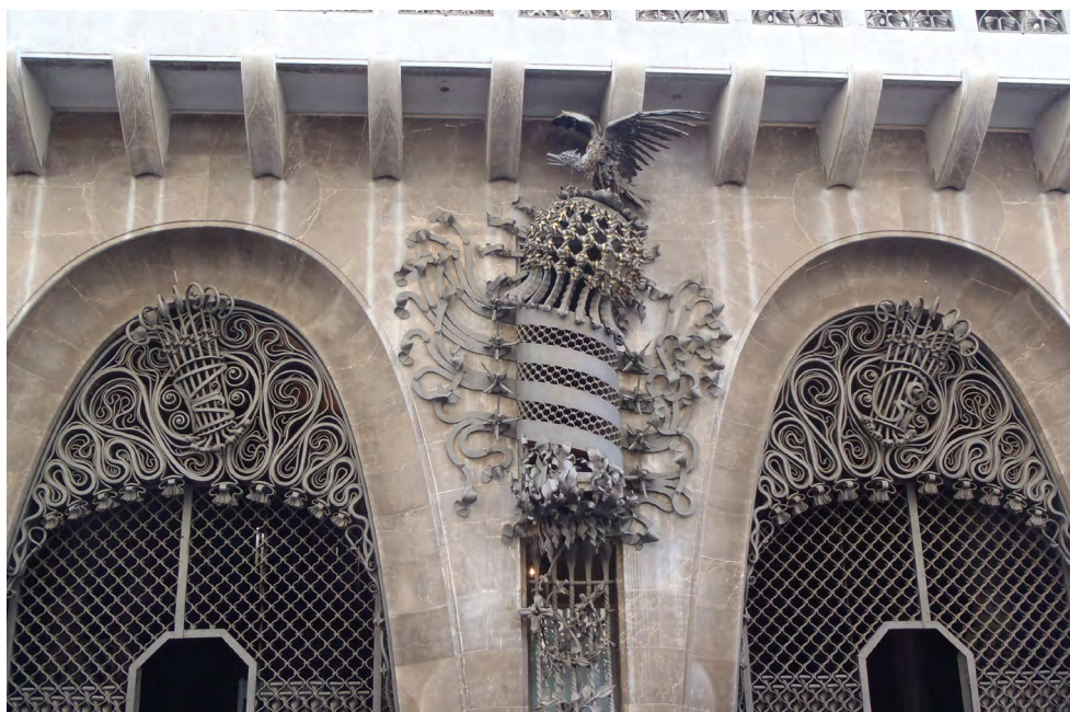
Fig. 6 Escudo en la fachada principal del Palau Güell
